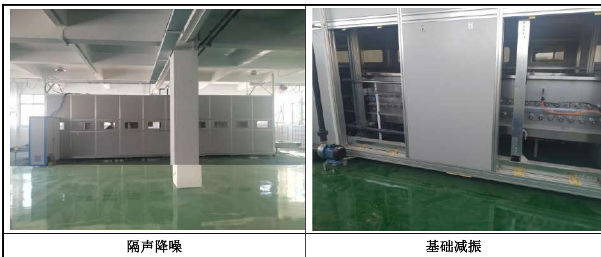
图 7 噪声防治设施现状照片
